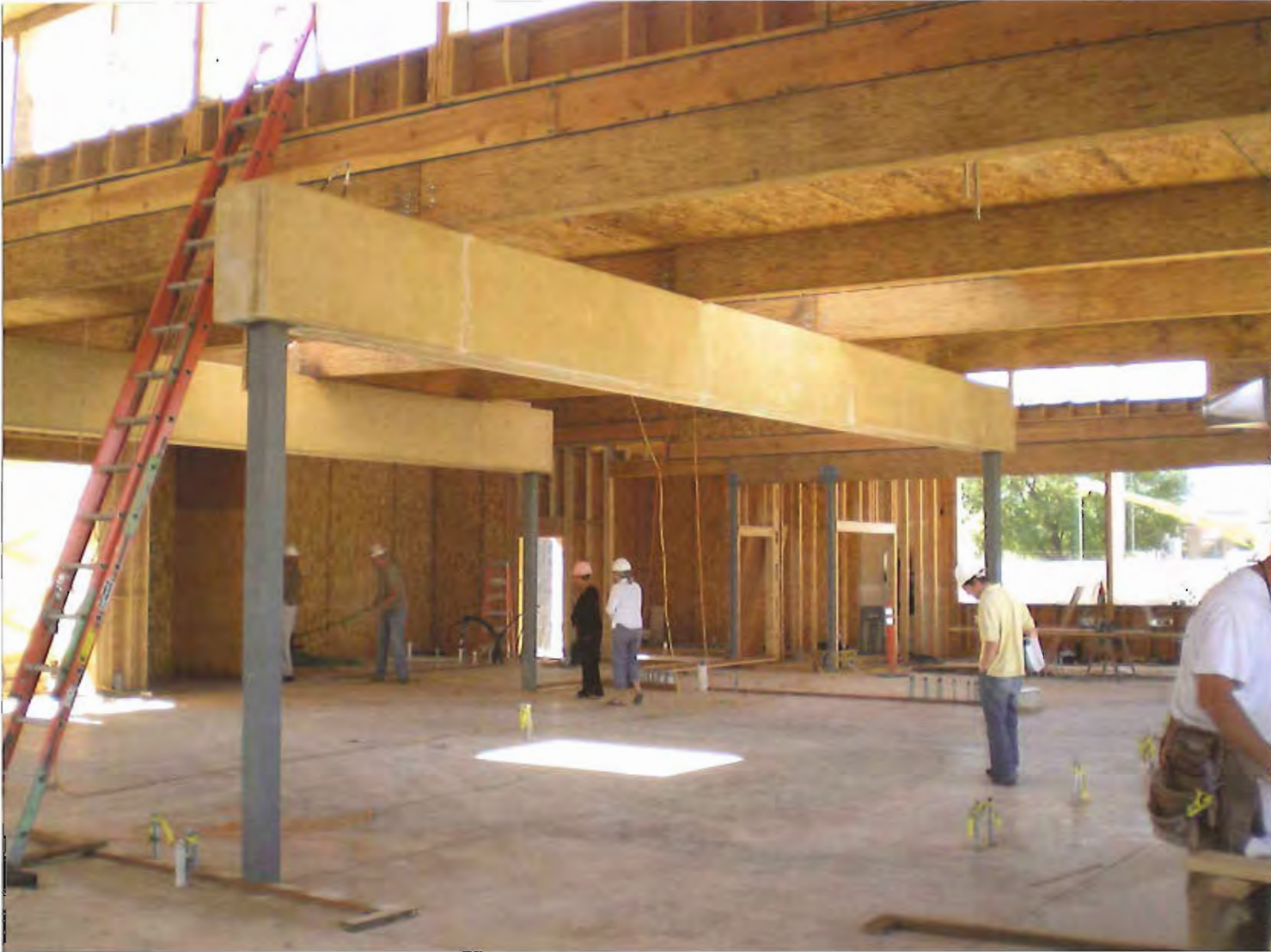
Actual precast load bearing beams. (June 2008)
